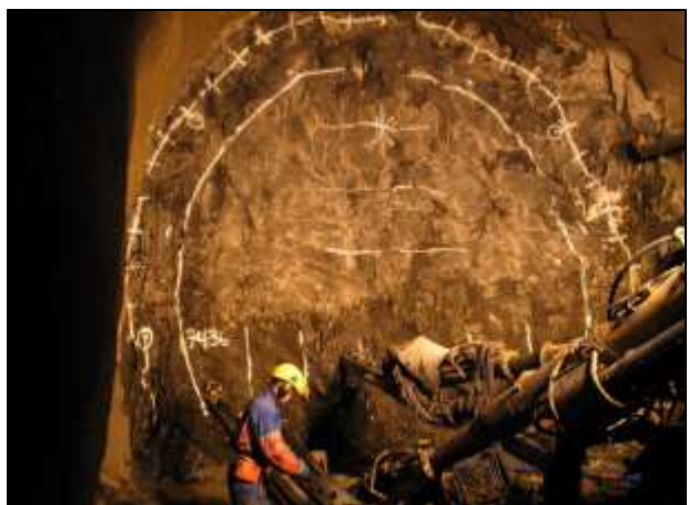
Mynd 4.3.3. Hleðsla og borun í Fáskrúðsfjarðargöngum (ljósmynd: Sigurður Oddsson, 2004).
