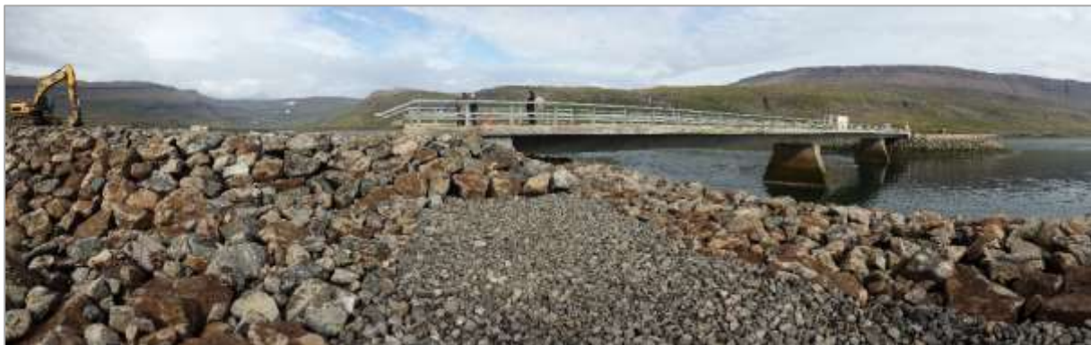
Mynd 4.2.3. Framkvæmdir við 117 m langa brú yfir Kjálkafjörð sumarið 2014 (ljósmynd: Sóley Jónasdóttir, 2014).
