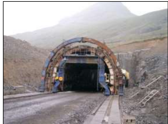
Mynd 4.4.2. Bygging vegskála í Fáskrúðsfjarðargöngum (ljósmynd: Sigurður Oddsson, ágúst 2004).
