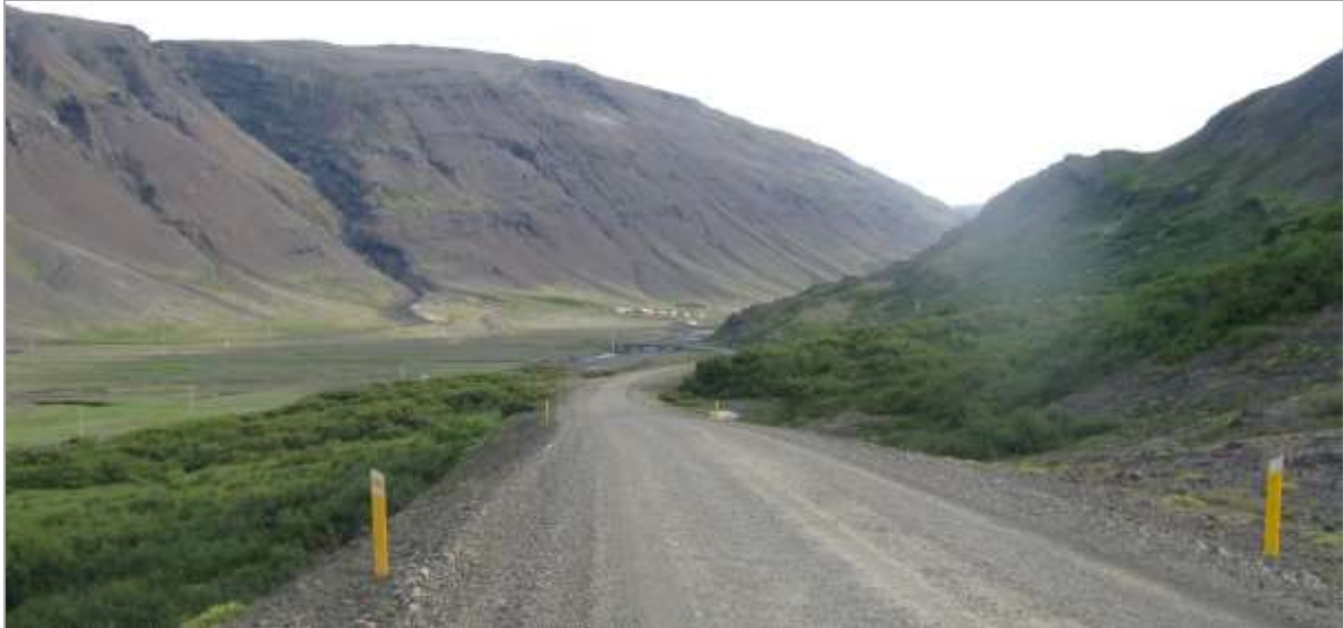
Mynd 1.10.1. Vestfjarðavegur við Djúpadal (ljósmynd: HA, 2012).
