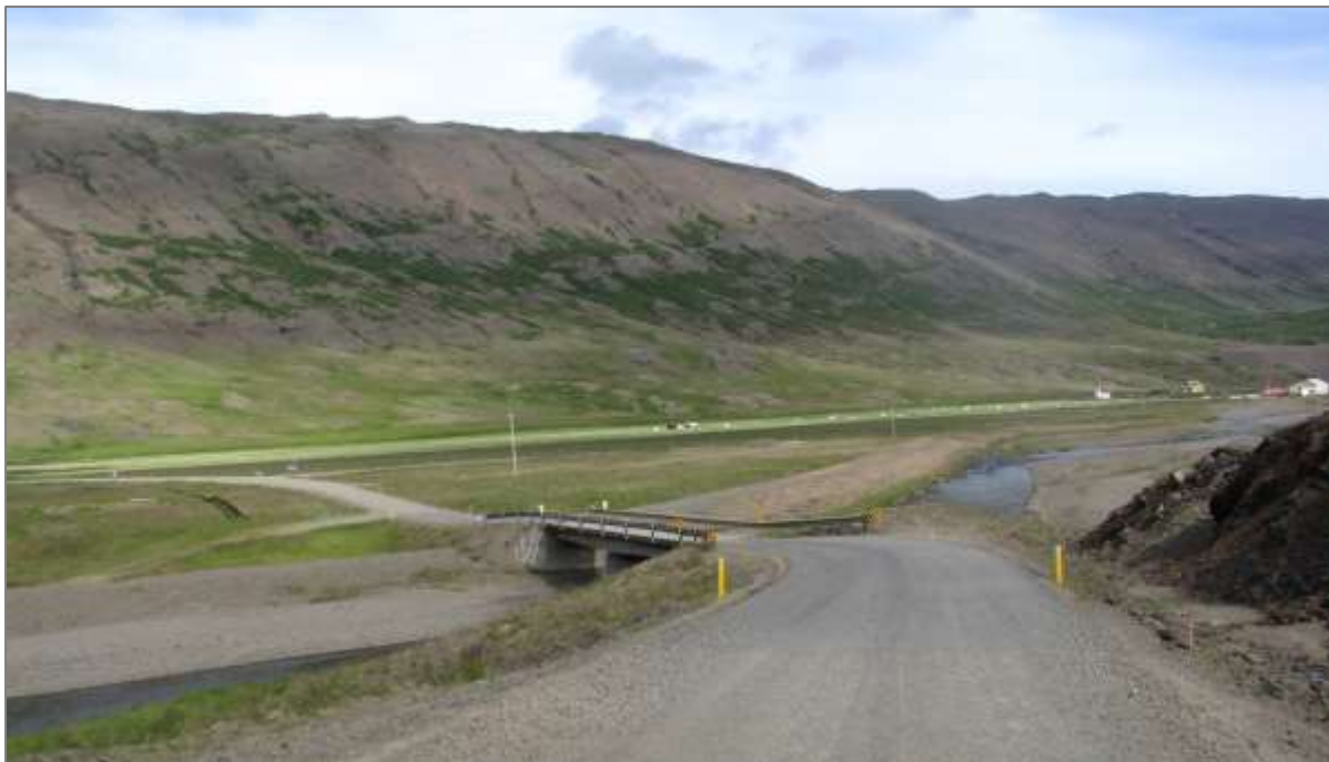
Mynd 2.1.4. Brú yfir Gufudalsá (ljósmynd: HA, 2012).
