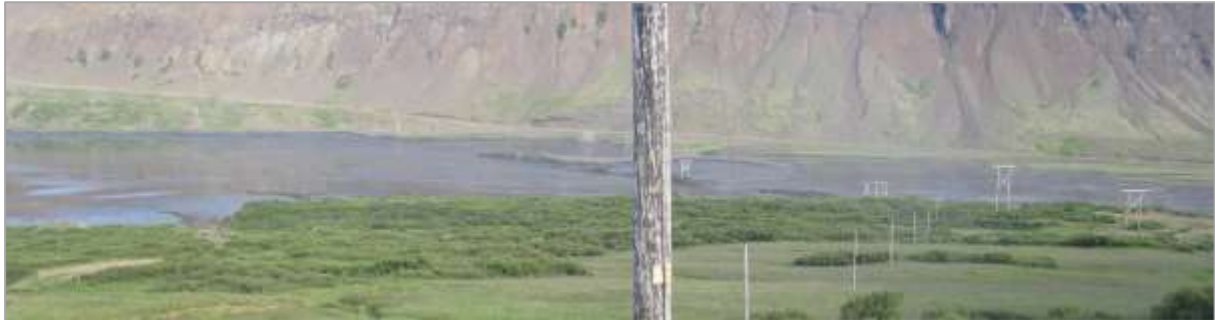
Mynd 6.2.5. Raflínur í Djúpafirði (ljósmynd: HA, 2012).
